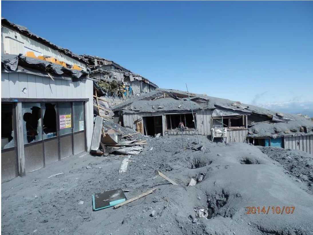
13. 噴石により、大きな被害のあった剣が峰山荘付近。(9次隊提供)
