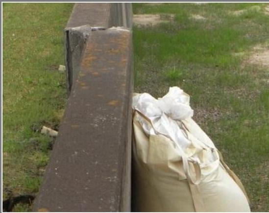
液状化による防油堤の沈下、
