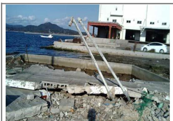
倒壊した防火塀と曲げられた通気管
