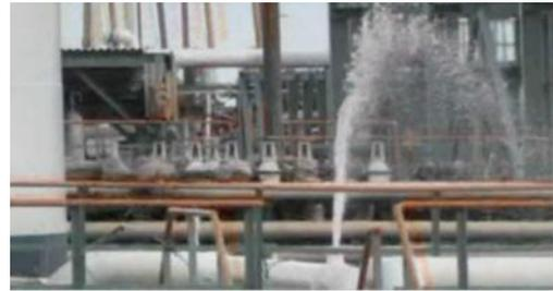
配管の破断部から噴出するガソリン
