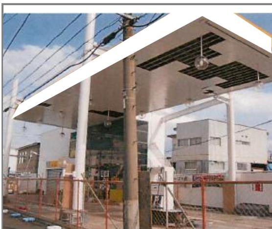
地震によりパネルが落下した建築物
