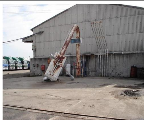
地震により破損した懸垂式固定給油設備
