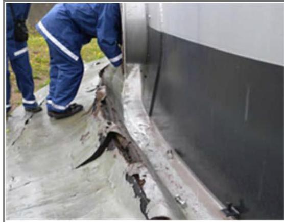
地盤の不等沈下によるタンクの沈下、
